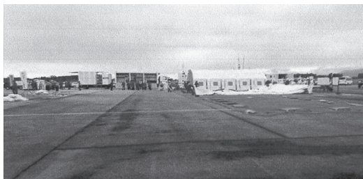
消火救難隊による救護所設営
