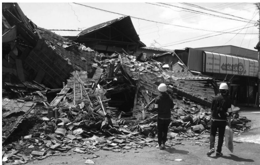
原型を留めなく破壊された家屋
