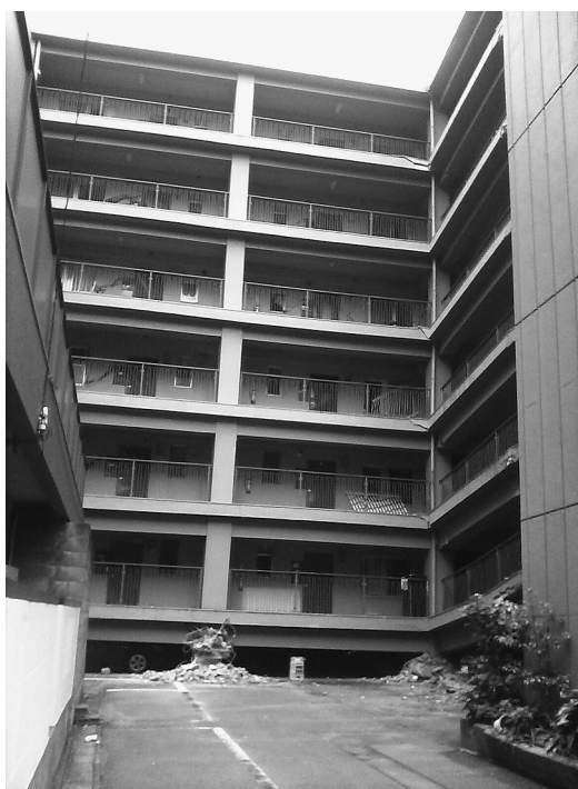
一階駐車場が潰れたマンション
