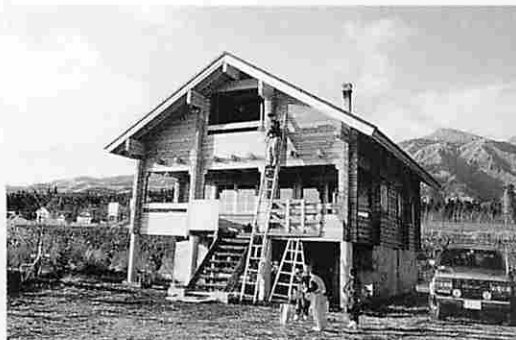
ログハウスに防腐剤を塗る
