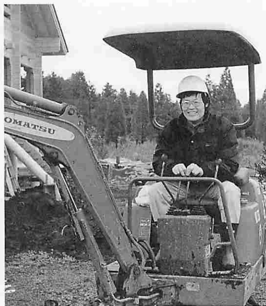
ユンボでの浄化槽・水道工事
